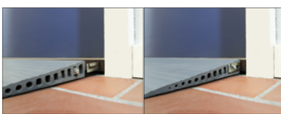
Abb. 2 Verwendung der Montagehalterungen.
